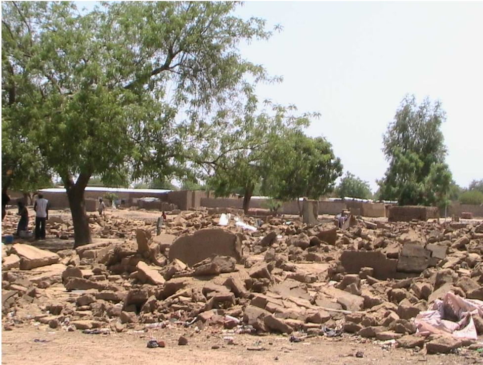
Destruction dans le quartier de Chagoua 2, pâté de maisons No 23 © Amnesty International
