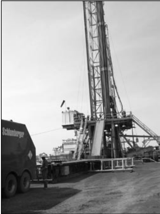
Une installation de forage en activité. Quelque 250 puits ont été forés dans la zone de développement des champs pétroliers de Doba. La plupart des puits ont une profondeur d'environ 2 000 mètres et peuvent être forés en quatre jours seulement. Une fois que la plate-forme de forage passe à un autre emplacement, tout ce qui reste est une petite tête de puits et un lopin de terre dégagé appelé « plate-forme d'exploitation ». L'écart entre la surface prévue et réelle occupée par les plates-formes d'exploitation abandonnées a fait l'objet de griefs à l'échelle locale. (Voir l'encadré no. 8.) (Photo : Ian Gary/CRS)
