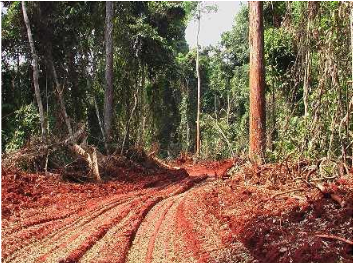
Figure 1 : Une des pistes illégalement ouverte au bulldozer par FIPCAM (2006) UFA 10 047
